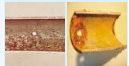
Lochfraß durch eingedrungenes Lötflut in einem Kupferrohr – 15 x 1 mm
